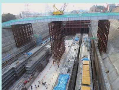
リニア中央新幹線「神奈川県駅(仮称)」新設工事現場 (令和6年11月9日撮影) 提供：産業労働局
